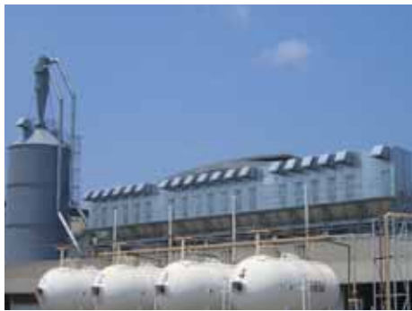
การขนส่งฝุ่นจากตู้กรองฝุ่น NFK เข้าไป สู่ไซโลผ่านพัดลม
