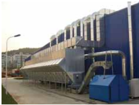
ตู้ NFK ที่มีสายพานลำเลียงไปยังถังเก็บ
