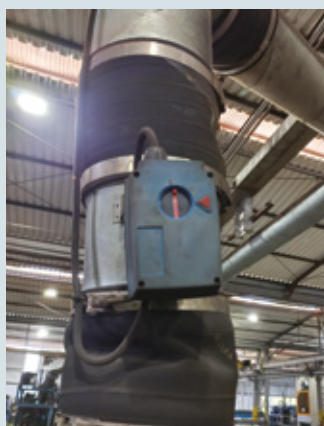
Manutenção de dampers
