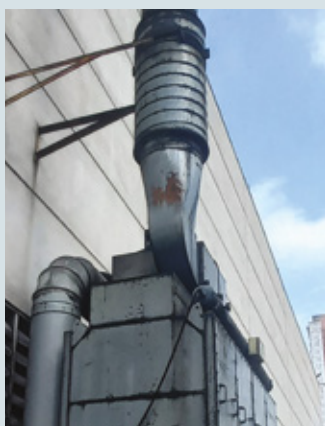
Corrosão e desgaste das juntas
